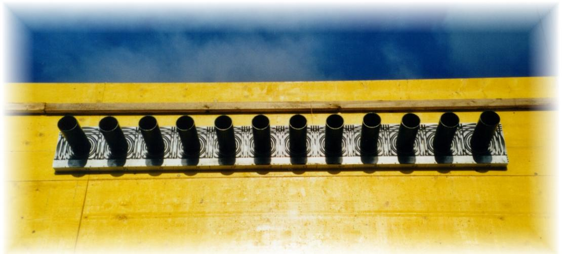
**Une batterie de 12 fourreaux P-Box en diamètre 75 mm.**
