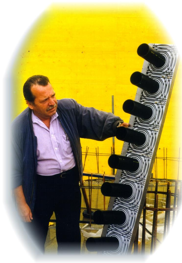
Des P-Box montés en batterie à l'aide d'un profil en "L"
