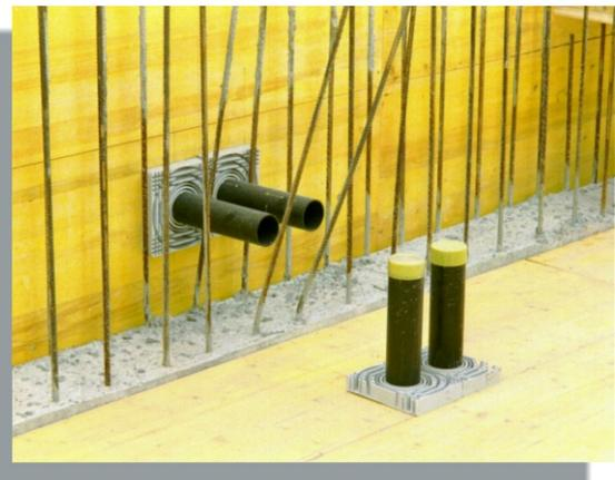
Le **P-Box** est un support pour la fabrication de fourreaux
